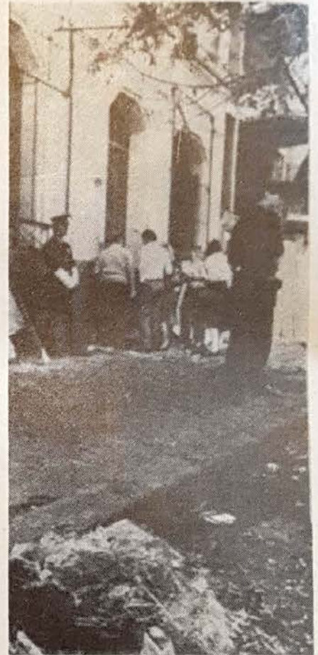
Un poderoso artefacto explosivo destruyó parte del frente y el acceso a un jardín de infantes de la comunidad judía, ubicado en el barrio de Palermo.
